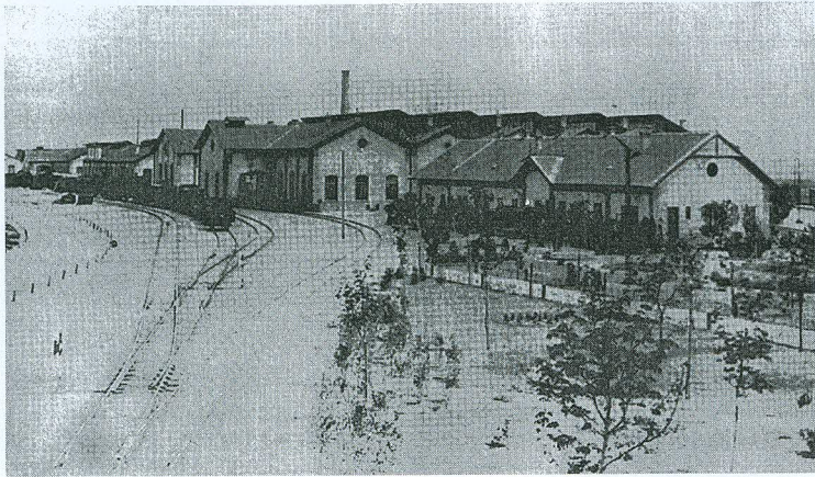
Pogled na strojarnički sklop s pješačkog mosta Petrinjska-Trnjanska, oko 1900. god. (iz dokumentacije g. Horvata)
